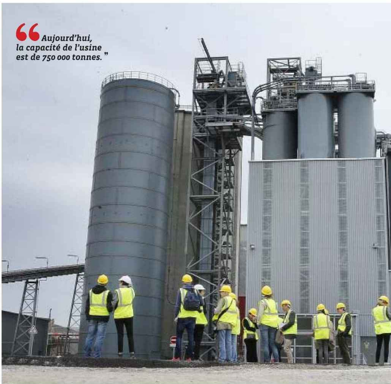
L’usine Ecocem de Dunkerque est équipée de silos de stockage de 36 m et d’un broyeur vertical d’une dizaine de mètres. PHOTOS ÉDOUARD BRIDE
