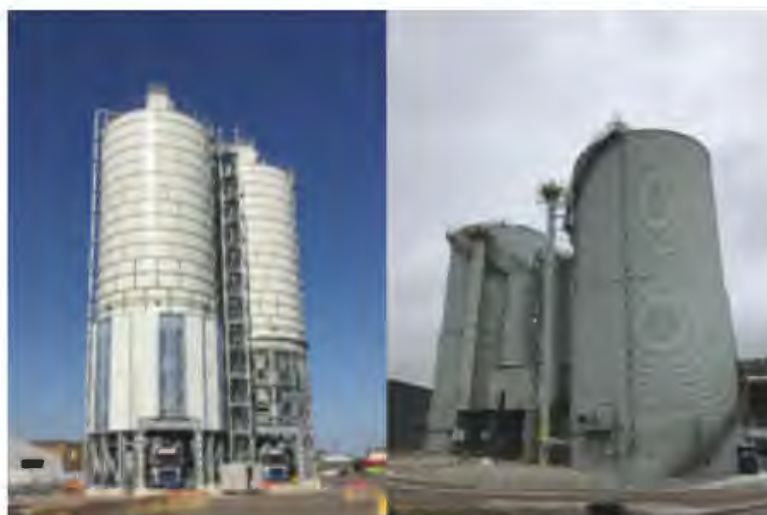
Dépôt de Runcorn à proximité de Manchester
