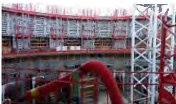
Projet ITER, construction du Tokamak
